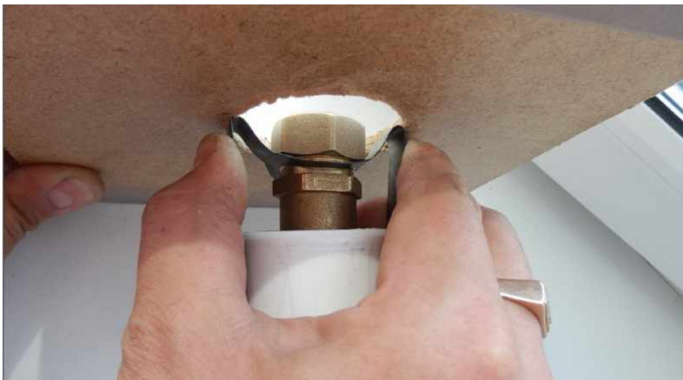
Фото 3. Сжатие упора перед монтажом в потолок
